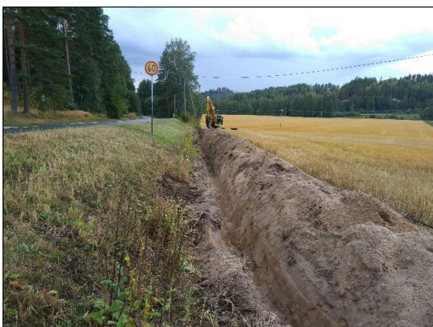
Vasemmalla maakaapelilinjan eteläpäätä pellon laidassa. Oikealla kaivetun ojan seinämä.
